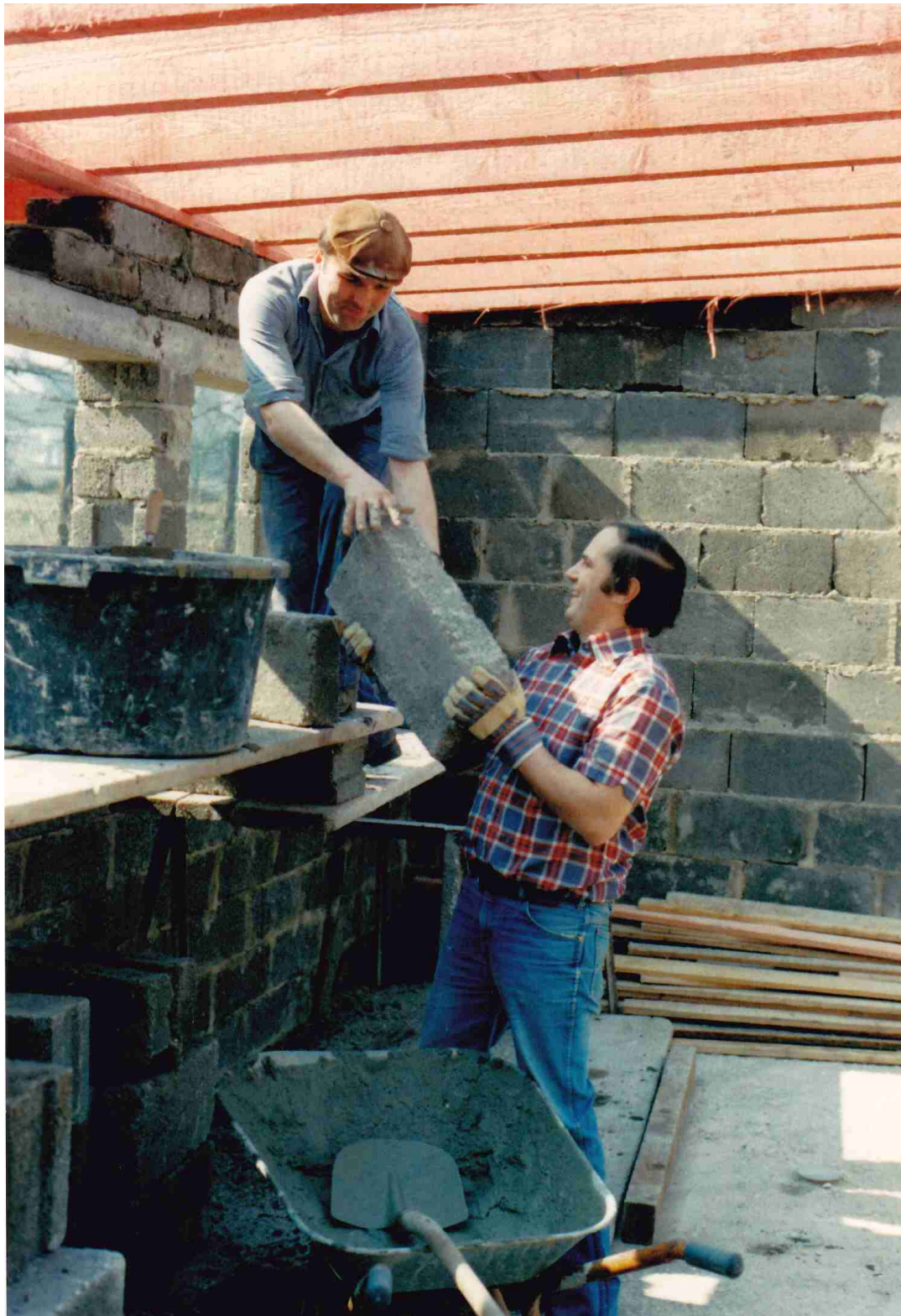
Foto: Arbeitseinsatz bei der Erweiterung des Gebäudes auf dem Sportplatz während der „Aktion Ortsverschönerung 1982“ (unten: Erhard Niemann, oben: Matthias Spohn)
